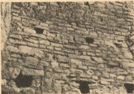
Innenwand des Schachtes B
