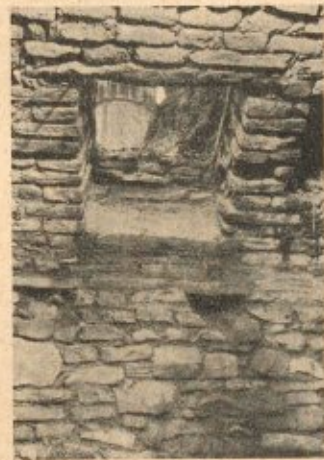
Gewölbe des Schachtes B
